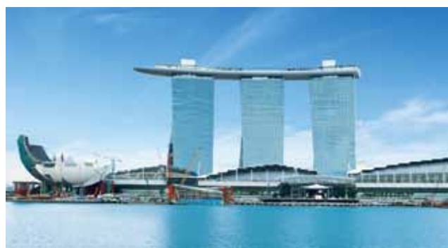
Marina Bay Sands, Singapur Spezialreinigung & Antirutsch-Imprägnierung / Kalkstein
