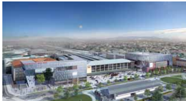
BahnhofCity Wien West, Wien Grundreinigung & Antirutsch-Imprägnierung / Terrazzo
