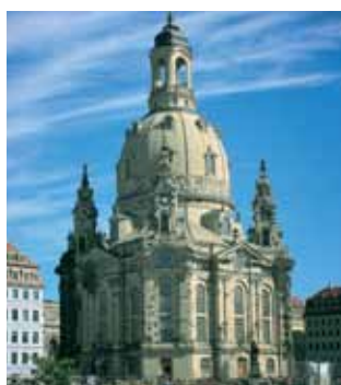
Frauenkirche, Dresden Spezialreinigung & Heiß-Imprägnierung
